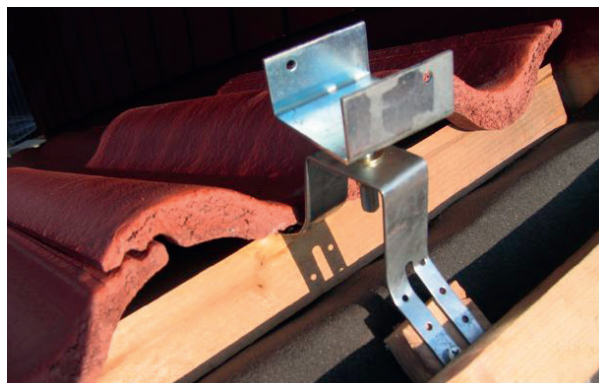
Monteringsbild 5. Lägg dit takpannorna och passa in dessa så de ligger bra, fäst pannorna.
