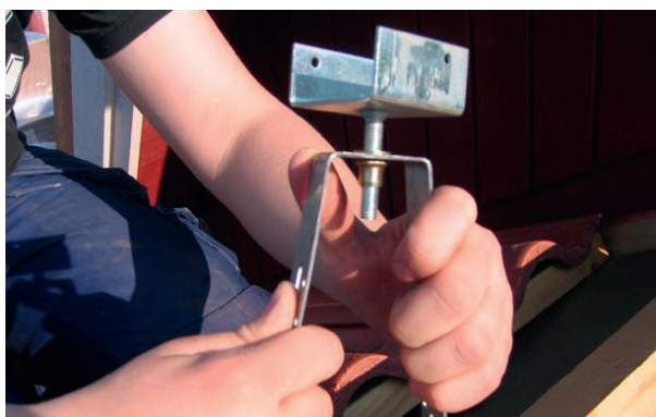
Monteringsbild 1. Böcka U-benen till lämplig vinkel, det gör du lätt för hand. Ställ förskruvningen i mittläge.
