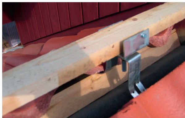
Monteringsbild 6. Lägg dit nockregeln/läkten och fäst den. Lägg sedan dit nocktätningen. Till sist, lägg på nockpannorna. Du har nu fått en optimal, ventilerad och rak nock.
