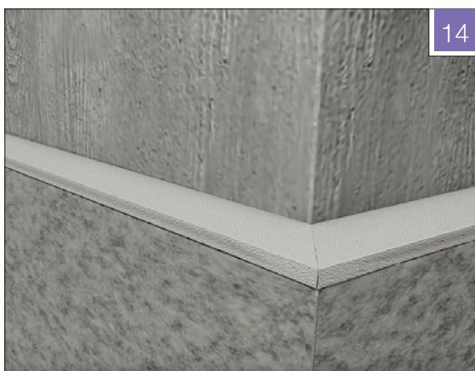
Fig. 14: När skivorna är färdigmonterade i önskad höjd monteras styrningspluggar i hålen i toppen av översta skivan. Avslut Thermodrän® monteras på samma sätt som Thermodränskivorna,
