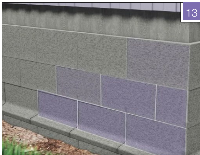
Fig. 13: Skivorna monteras i förband. Skivorna justeras/kapas för anpassning till terränghöjd, ca 50-100 mm under färdig marknivå. Kapning av skivan görs med glödniv/glödtråd eventuellt kan fogsvans användas.
