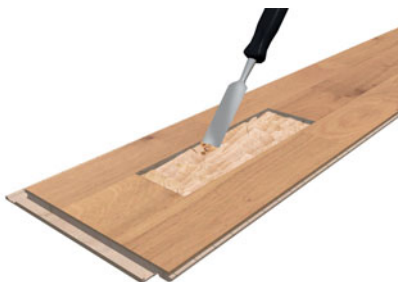
Mejsla ut staven och 2 mm av mellanlagret med ett stämjärn.
