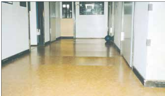
Fukt har trängt igenom den underliggande folien och har medfört att spånskivan svällt, nedbrytning av lim och blåsbildning på mattan.
