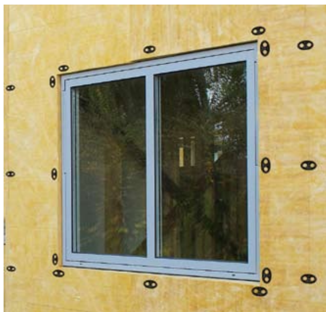
Färdigmonterade ISOVER IsoPigg på ISOVER Fasadskiva 32
