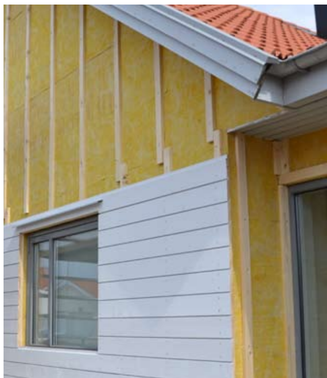
Färdigmonterade ISOVER IsoPigg på ISOVER Fasadskiva 32
