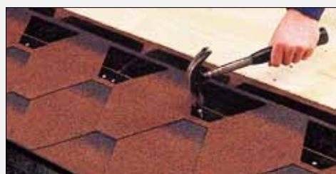
Isola Takshingel klisterfält är ytterligare förbättrade för att ännu bättre klara de höga krav som norskt klimat ställer.
